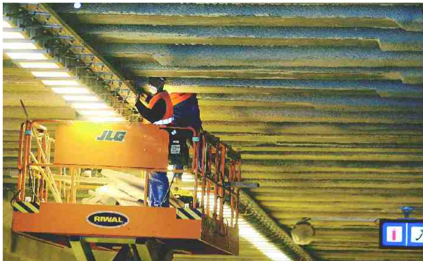
Odstranjevanje protipožarnega ometa v šentviškem predoru
